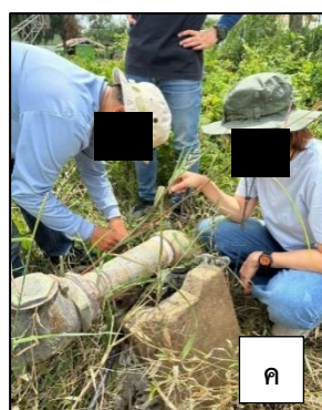
รูปที่ 5.2.4-6 การวัดระดับน้ำใต้ดินจากบ่อบาดาลบริเวณพื้นที่โครงการประตุระบายน้ำท่านางงาม จังหวัดพิษณุโลก ในช่วงเดือนกรกฎาคม 2567 (ฤดูฝน)
