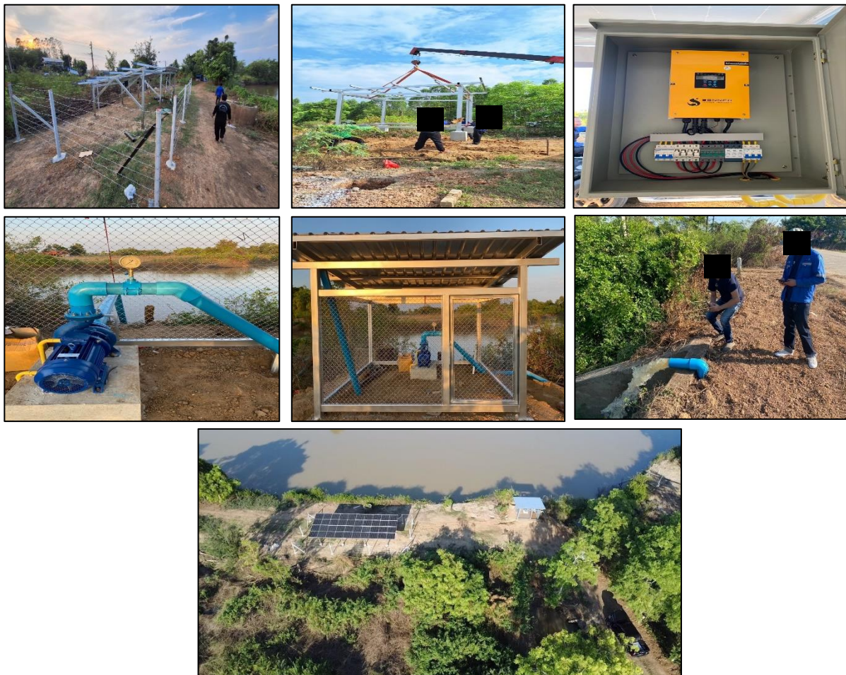
รูปที่ 5.1.1-6 สถานีสูบน้ำด้วยระบบ Solar Cell
